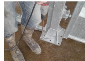
■ Éléments spittés dans le béton : Installation facile et modifiable par la suite si les besoins évoluent.
